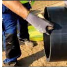
Die bearbeiteten Rohrflächen mit PE Reiniger und nicht faserndem, sauberen Tuch reinigen. (Ausschließlich DVGW VP 603 zertifizierten Reiniger verwenden!) Vollständiges Abdampfen des PE Reinigers abwarten und Verunreinigungen der Schweißflächen verhindern.
