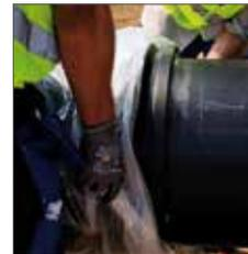
Nach beendetem Schweißvorgang die Meldung am Schweißgerät überprüfen. Anschließend das Schweißkabel entfernen. Auf Spannungsfreiheit achten, bis die Abkühlzeit vorbei ist. Erst dann Halteklemmen bzw. Unterbauungen entfernen.
