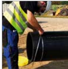
Schweißflächen des Formteils reinigen. Anschließend das Produkt aus der Verpackung nehmen, ohne die Schweißflächen zu berühren und gerade bis zur Markierung, bzw. bis zum Mittelanschlag, auf das Rohr schieben.
