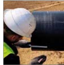
Den Schweißvorgang gemäß Bedienungsanleitung des Schweißgerätsherstellers ausführen. Den Schweißvorgang kontrollieren und überwachen.
