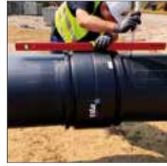
Den zu schälenden Rohrbereich [Einstecktiefe (L1) = Hälfte der Gesamtlänge (L)] am verpackten Produkt messen und plus 2-5 cm Zugabe auf dem Rohr mit Permanent Marker anzeichnen.
