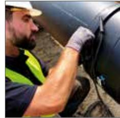
Rohrdurchmesser mittels Umfangmaßband vor und nach dem Schälvorgang kontrollieren. Bei Unrundheiten des Rohres im Schweißbereich Rundrückklemmen verwenden.
