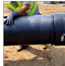
Den Rohrleitungsgraben erst nach bestandener Druckprüfung verfüllen.
